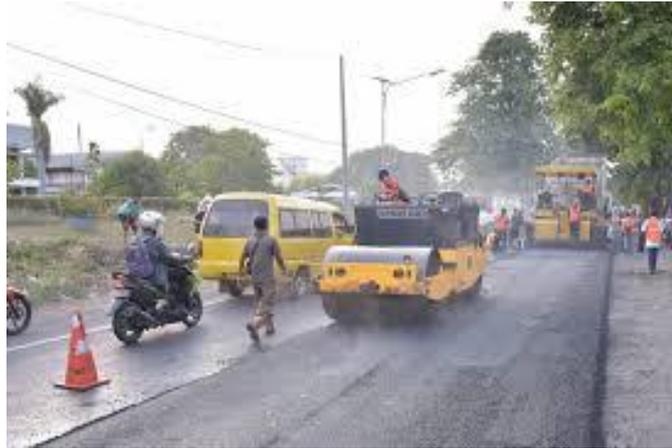
Gambar 8. Perkerasan Jalan Dengan Overlay
